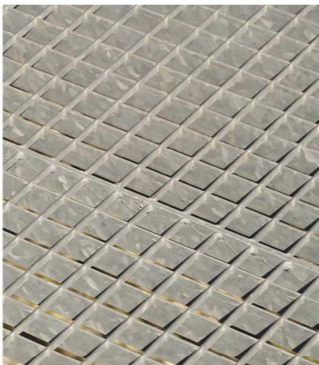
Die Gitterstruktur setzt sich aus Tragstäben und verdrehten Querstäben mit einem Durchmesser von 5 mm oder 6 mm (je nach Tragstabdicke) zusammen. **Die Tragstäbe dienen zur Aufnahme der auf den Gitterrost einwirkenden Lasten. Demgegenüber sorgen die Querstäbe für Positionierung und Stabilität der Querstäbe.**
